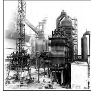
Будівництво домни на Криворіжсталі
