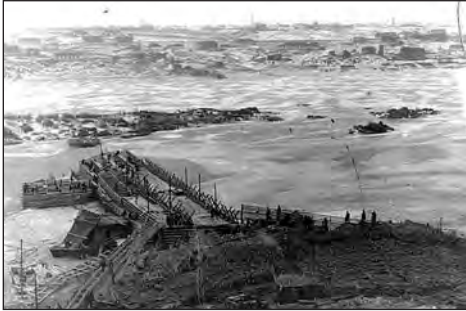
Початок будівництва Дніпрогесу
